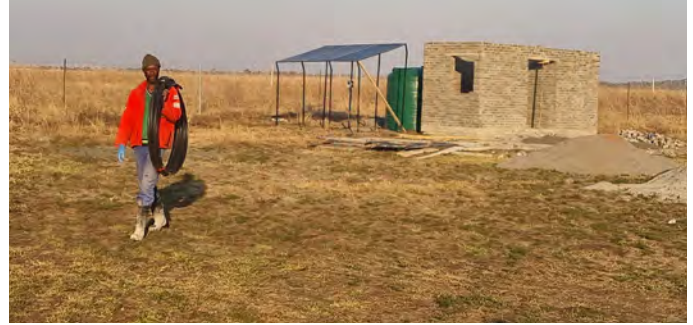
Bau der Toiletten und Duschen mit Grundwasser über die Solarpumpe
