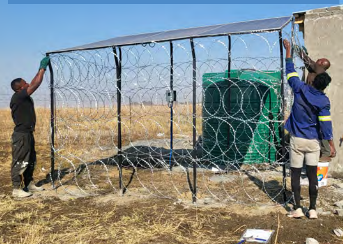
Durch Stacheldraht werden unsere Wasserpumpe und die Solarzellen vor Diebstahl geschützt
